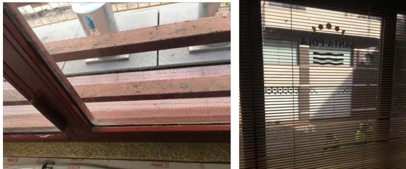
**Imagen 3. Carpintería aluminio sin RPT+ vidrio monolítico - Dispositivo interior de control solar**
