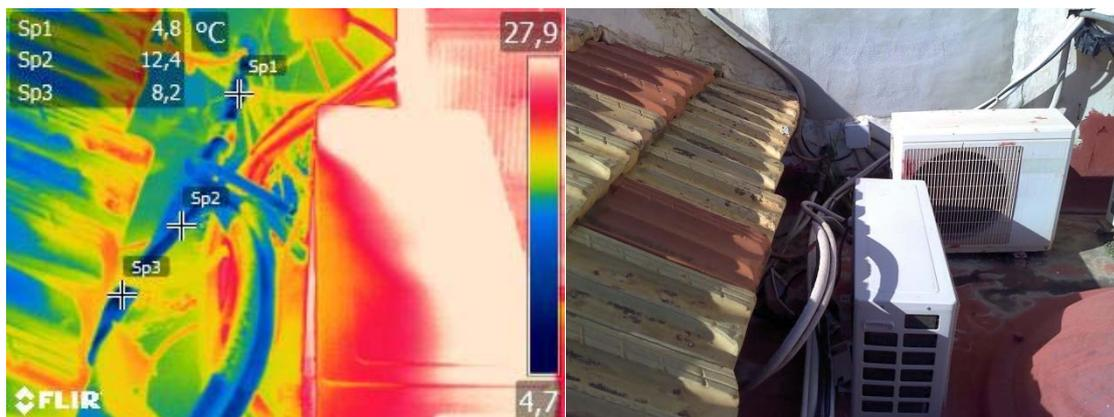
**Imagen 25. Tramos de líneas de refrigerante con aislamiento deficiente. Tª superficial 10,5°C**
