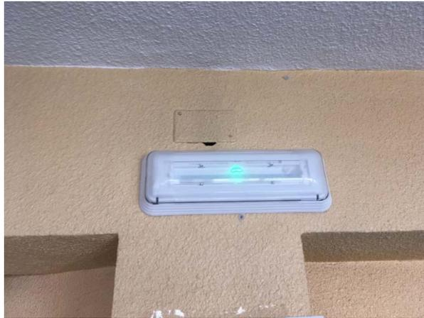
**Imagen 17. Alumbrado de emergencia con tecnología LED**
